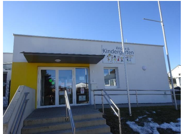
Außenansicht der Krippe und des Kindergartens
